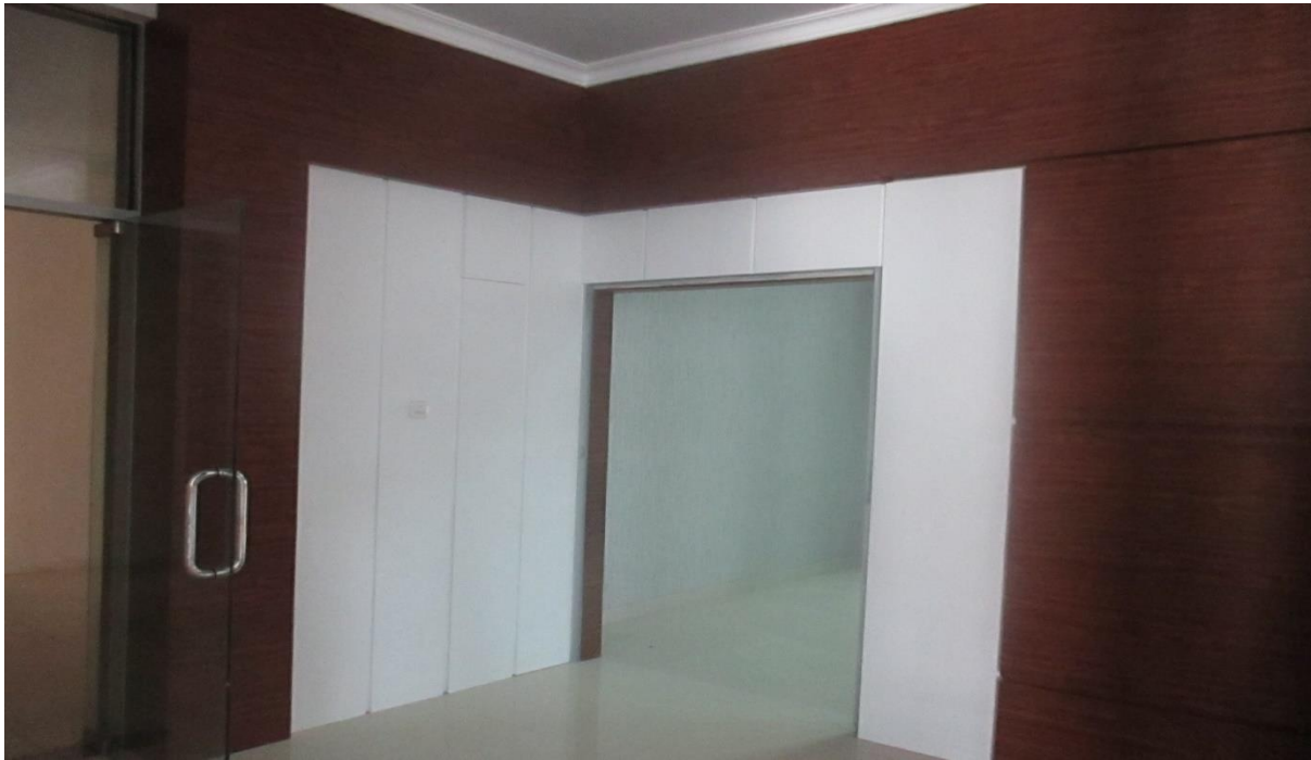
Gambar 8. Pengembangan Gedung Aula Kantor Regional XII BKN Tahun 2017
